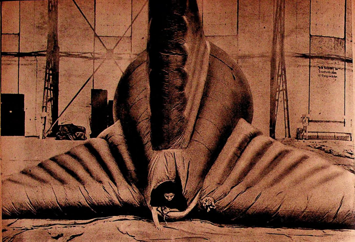
**JONAS AU SORTIR DE LA BALEINE.** L'ouvrière d'une usine allemande spécialiste dans la fabrication des ballons captifs militaires, s'est introduite dans la saucisse gonflée d'air, afin d'en contrôler l'étanchéité. De l'intérieur obscur du ballon l'ouvrière a repéré les moindres fissures et, d'une pression sur la souple paroi les a indiquées à sa collègue demeurée au dehors: une simple pièce a suffi pour remédier aux fuites.
