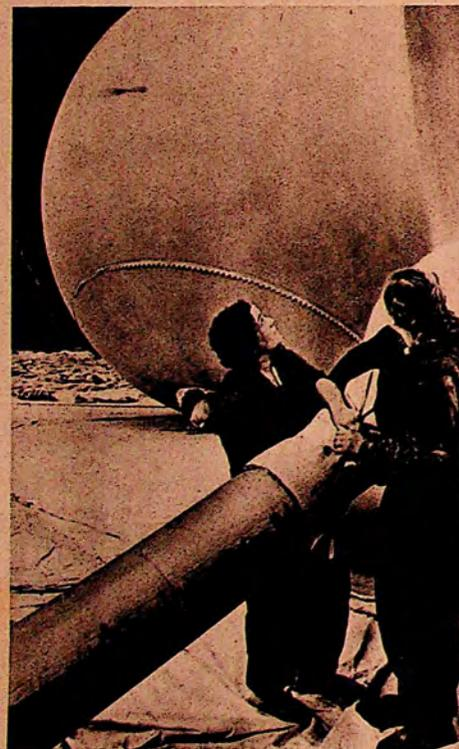
**LA LIMITE DE RESISTANCE A LA PRESSION INTERIEURE.** Le raccord souple que deux adroites jeunes filles ont relié au ballon, permet de faire passer dans l'enveloppe, l'air fourni par les pompes électriques
