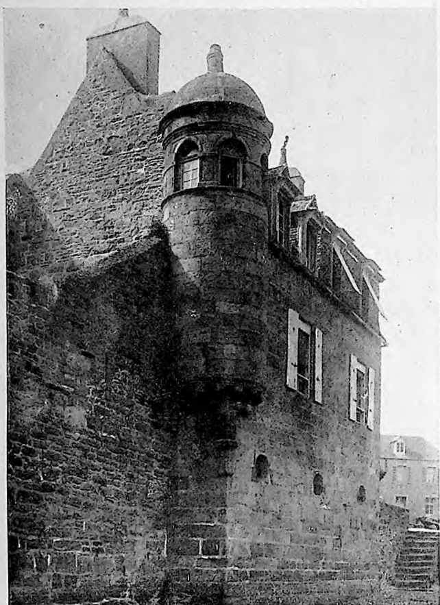
DÉTAIL D'ARCHITECTURE de la maison prébendale, à Roscoff. La tourelle en encorbellement qui se termine en lanterne est bien dans l'esprit de la Renaissance.
