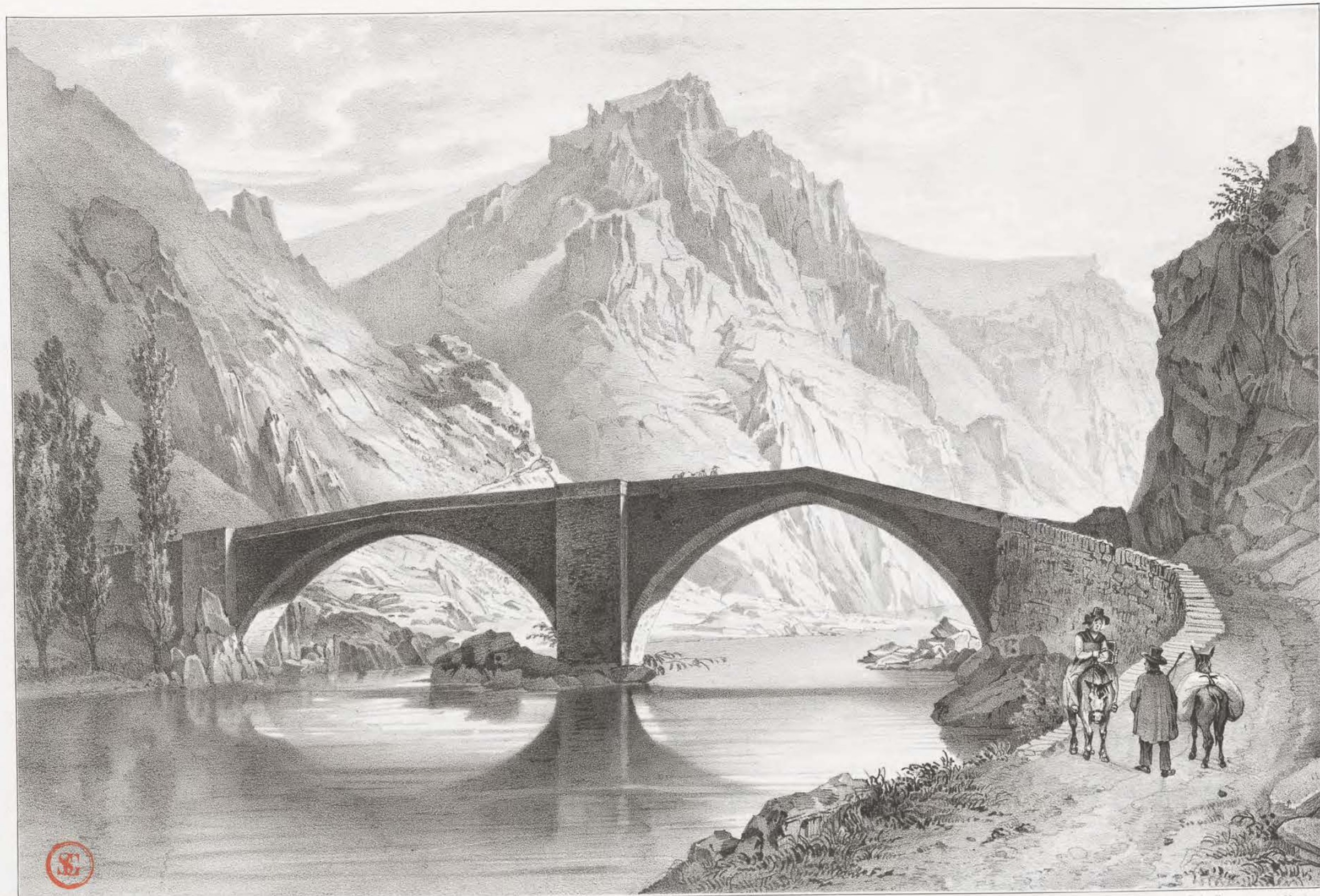
PONT DE TREBOUL.
