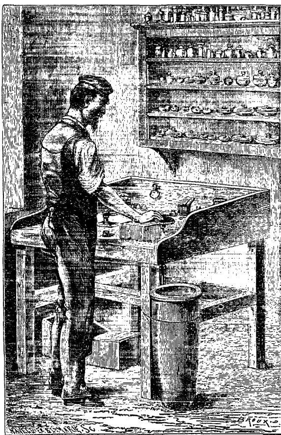
FIG. 6. — Ouvrier opticien polissant au tour.
