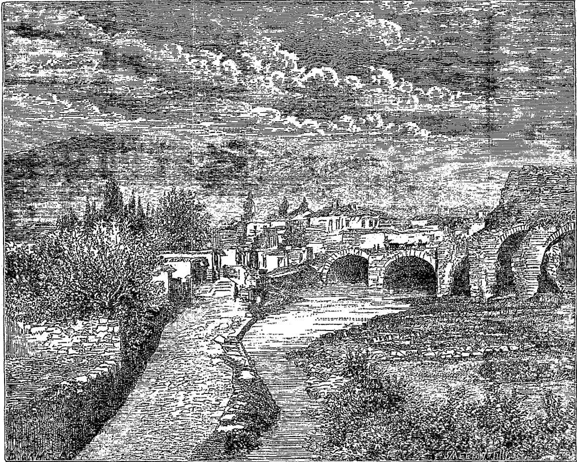
Pergame (Asie Mineure). — Double tunnel que l'on suppose être de la période attalique, deux siècles avant Jésus-Christ. Dessin de Lancelot, d'après une photographie de Svoboda.
