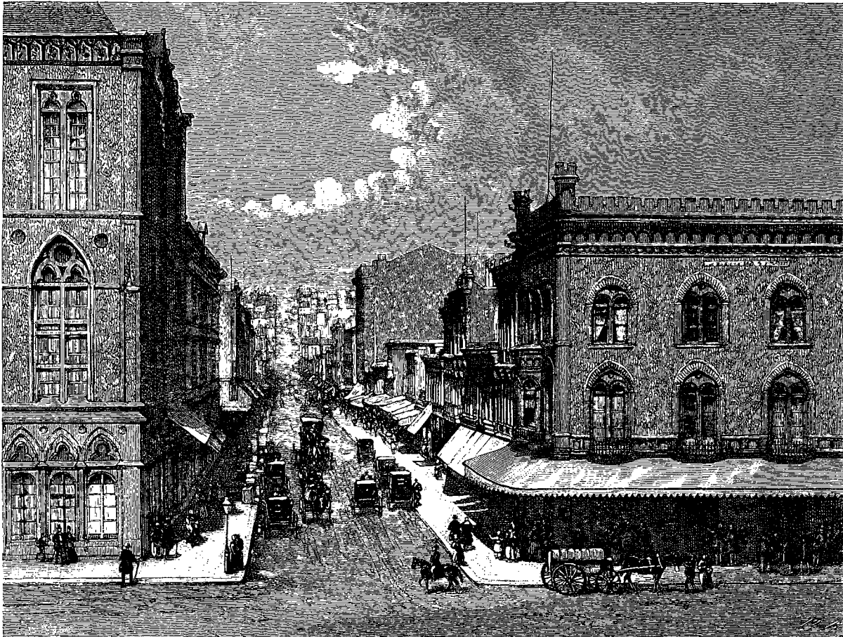
Vue de Montgomery-street , à San Francisco. — Dessin de Ph. Benoist, d'après une photographie.
