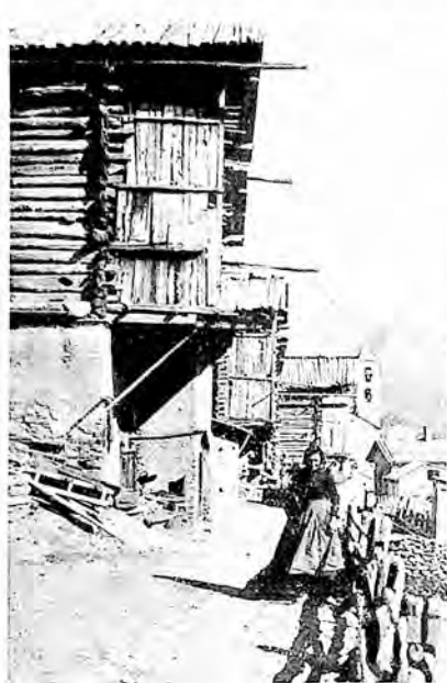
DÉTAIL D'UN CHALET à Saint-Véran. Le sous-bassement est en maçonnerie, tandis que le dessus est entièrement en bois.
