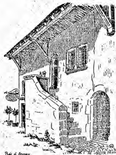
Façade savoyarde, très caractéristique avec son avant-toit largement débordant et soutenu par des poteaux, sa porte d'entrée cintrée, ses petites fenêtres, dont deux jumelées et à accolades.
