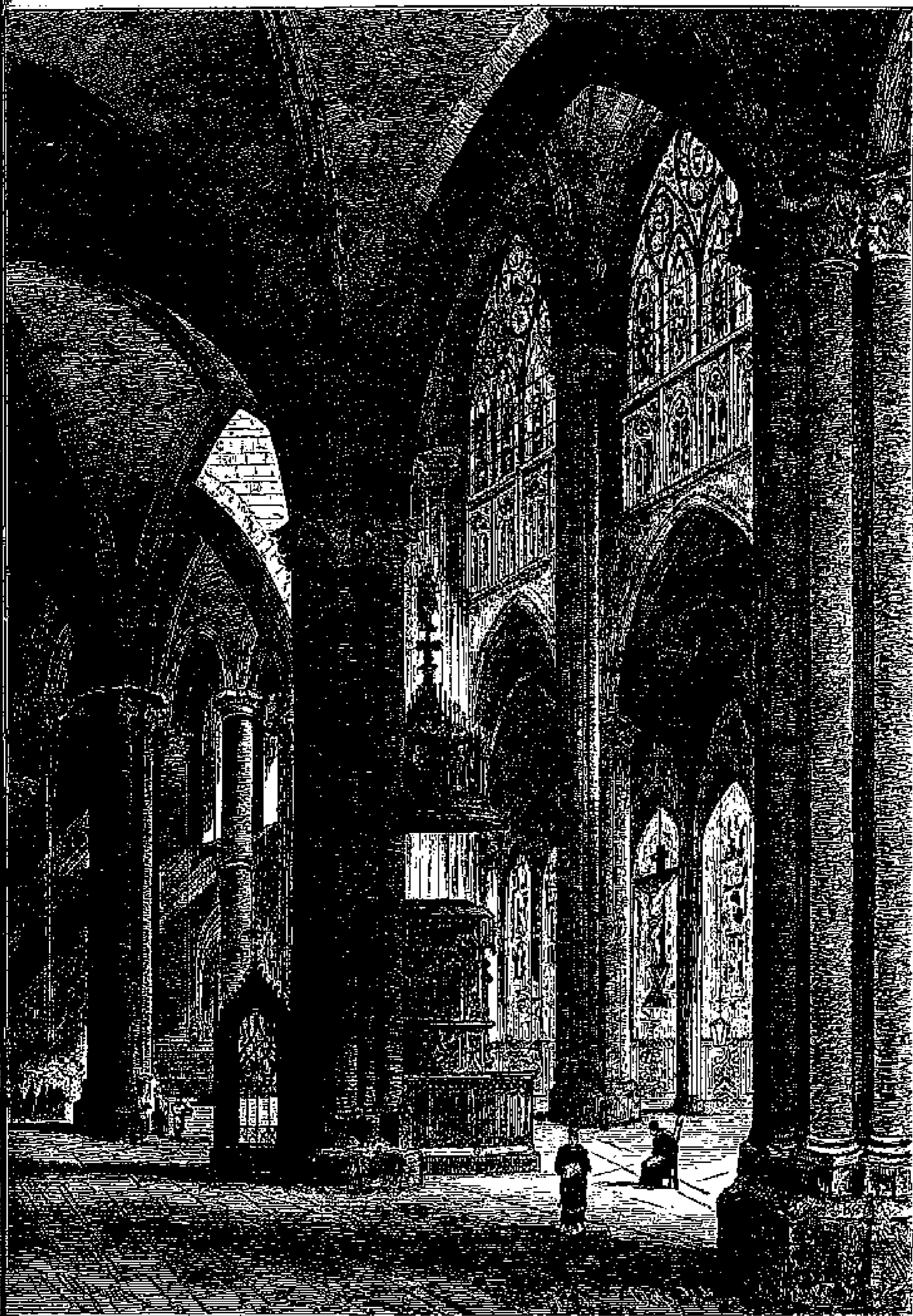
FIG. 25. — CATHÉDRALE DE STRASBOURG. Triforium ajouré simulant le prolongement de la fenêtre supérieure.
