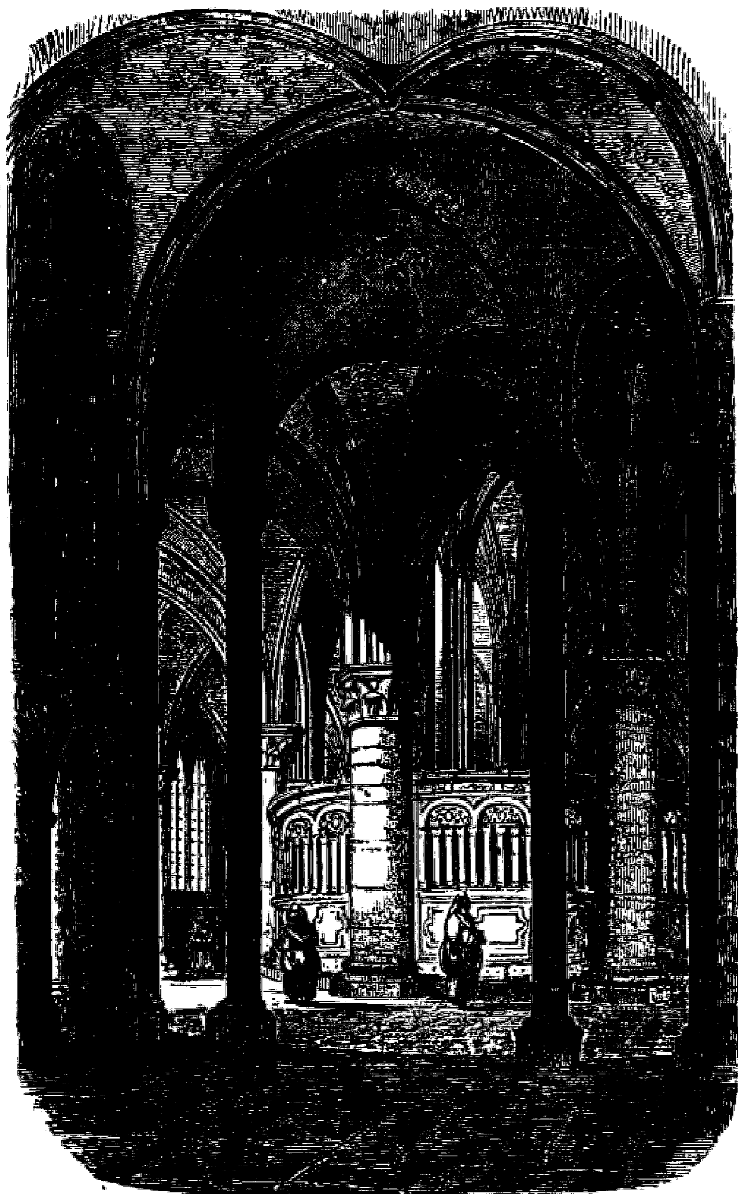
FIG. 15. — SAINT-REMI DE REIMS. Spécimen de la croisée d'ogives et de la colonne du gothique primitif.
