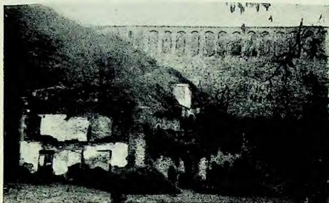
Cliché LVC Les ruines du Moulin à Papier du Cotatay (1942)
