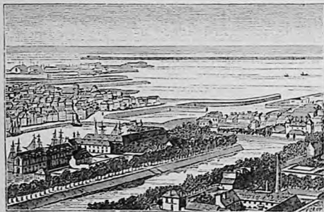
CHERBOURG ET SA DIGUE. — La rade de Cherbourg était une des plus belles de la Manche, mais elle était ouverte du côté de la mer et exposée aux tempêtes ou à l'attaque des ennemis. C'est pour la fermer qu'on a construit cette immense digue, œuvre unique en son genre, qui est une sorte d'île faite de main d'homme et au milieu de laquelle s'élève un fort. Cherbourg est maintenant un des plus beaux de nos cinq arrondissements maritimes dans lesquels on a divisé nos côtes.
