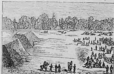
LE POLYGONE DE VINCENNES. — On appelle polygon le lieu où les artilleurs s'exercent à construire des batteries, à manœuvrer et à tirer les canons. Au milieu d'un vaste terrain vide se trouve une lunette en terre qui sert de point de mire aux boulets. Les artilleurs sont à une grande distance de cette lunette, et, d'après des calculs exécutés sur un carnet, ils tournent la gueule du canon dans la direction voulue et lancent la boulette.
