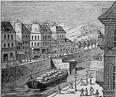
PONT JOURNAT SUR LE CANAL DU MIDI À CETTE. — Les canaux ne sont pas toujours assez profondément creusés pour que les bateaux puissent passer sous les arches des ponts. Afin que les bateaux ne soient pas arrêtés au passage, on a inventé les ponts tournants qui s'ouvrent par la molette ou tournent tout en bas sur eux-mêmes. — Cette, qui par son canal du Midi communique avec l'Océan, est, après Marseille, notre port de commerce le plus important de la Méditerranée. Elle fait un grand commerce de vins et eaux-de-vie et compte 30 000 hab.
