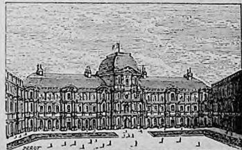
LA TOUR DU LOUVRE à PARIS. — Le mot Louvre vient de loup , parce que ce palais a été bâti sur la place d'un ancien rendez-vous de chasse au bord de la Seine dans une forêt autrefois peuplée de loups. C'est le plus vaste et le plus beau palais de Paris. C'est dans les bâtiments représentés par la gravure qui se trouve le Musée du Louvre, où sont réunis les tableaux et les statues les plus célèbres de tous les peintres et statuaires du monde.
