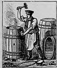
LE TONNELIER. — Pour rendre plus flexibles les douves qu'il veut recourber et assembler, le tonnelier allume dessous un feu de copeaux. En bas de la page, on voit les anneaux de cercles en bois ou en fer.
