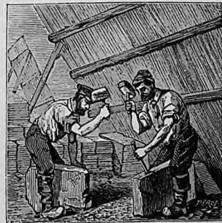
ARDOISIERS D'ANGERS. — Quand les ardoises ont été arrachées de la carrière par gros blocs, on les foud au moyen de coins et de pics; on obtient ainsi des feuilles de plus en plus minces. De nos jours, on a inventé une machine au moyen de laquelle on foud les ardoises avec rapidité.
