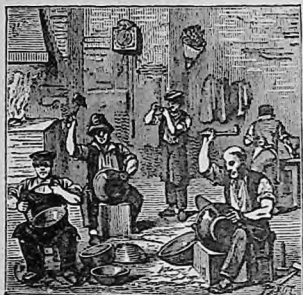
CHAUDRONNERIE D'AURILLAC. — La chaudronnerie est l'art de fabriquer tous les ustensiles en métal, comme ceux qui servent à faire chauffer l'eau et les aliments. La petite chaudronnerie fabrique les chaudrons de cuisine, les casseroles, les poêlons, etc. La grosse chaudronnerie fabrique les énormes chaudrons des locomotives ou des bateaux à vapeur, les cuves des tentatives, etc. L'Auvergne et la Normandie sont les centres de la chaudronnerie.
