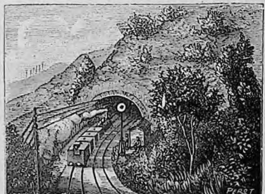
TUNNEL DE LA NORTHE, PRÈS DE MARSEILLE. — Un tunnel est un passage pratiqué sous terre qu'à travers une montagne, dans lequel s'engagent les trains de chemin de fer. Le plus grand tunnel de France a été longtemps celui de la Northe, qui a près de 5 kilomètres de longueur. Un autre tunnel, plus grand encore, a été construit pour mettre en communication la France et l'Italie; c'est celui du mont Cenis, dont la longueur dépasse 12 kilomètres.
