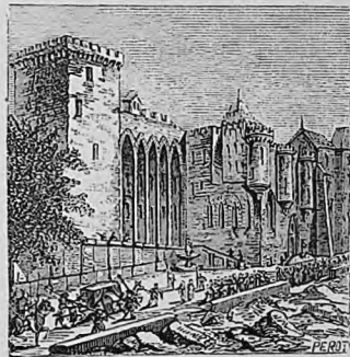
AVIGNON ET LE CHATEAU DES PAPES. — Avignon (40 000 hab.), ancienne capitale du comtat Venaissin, sur le Rhône, servit autrefois de résidence aux papes. On y voit encore leur palais, majestueux monument du quatorzième siècle.
