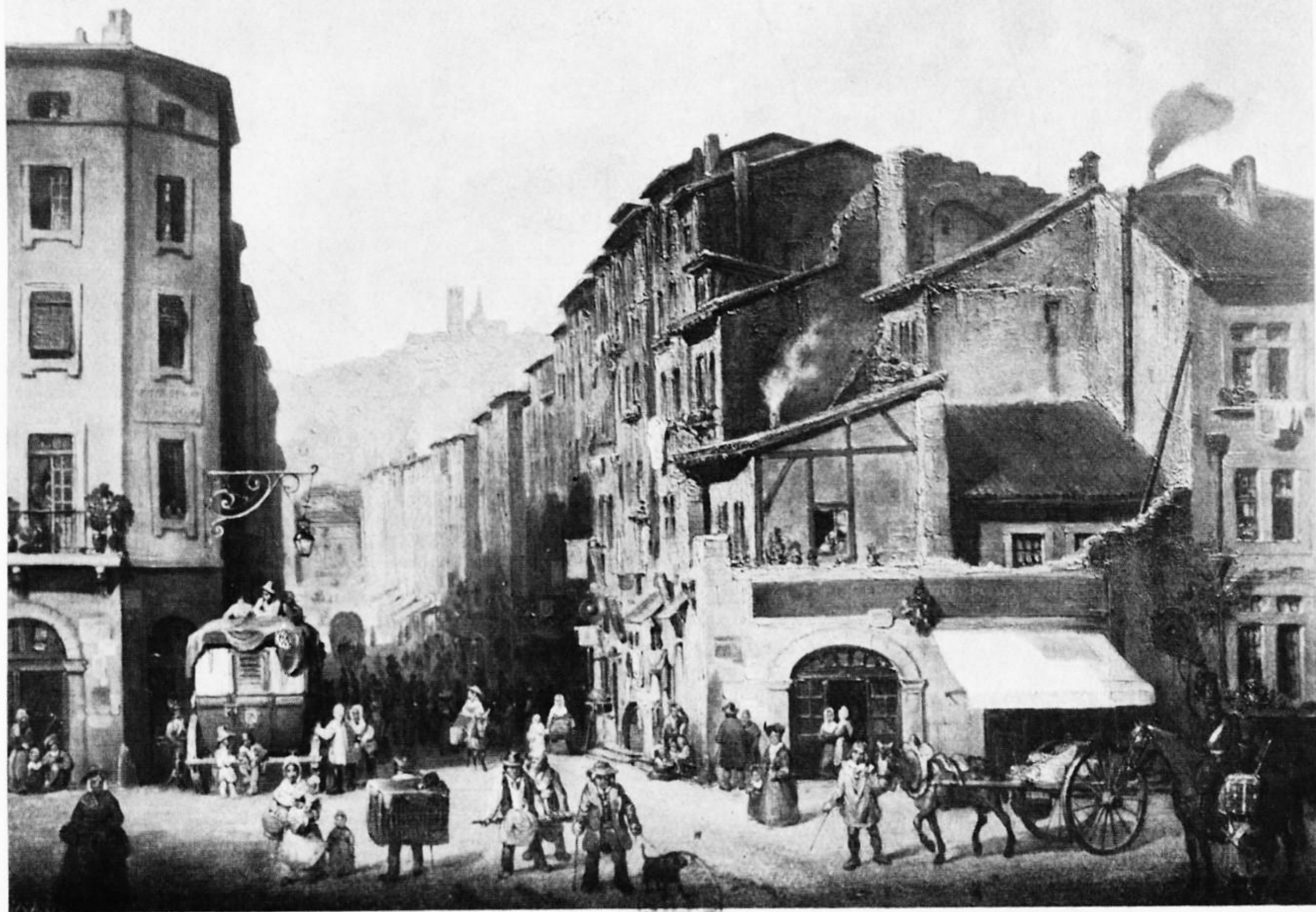
Entrée de la rue de la Barre vers le pont de la Guillotière.
