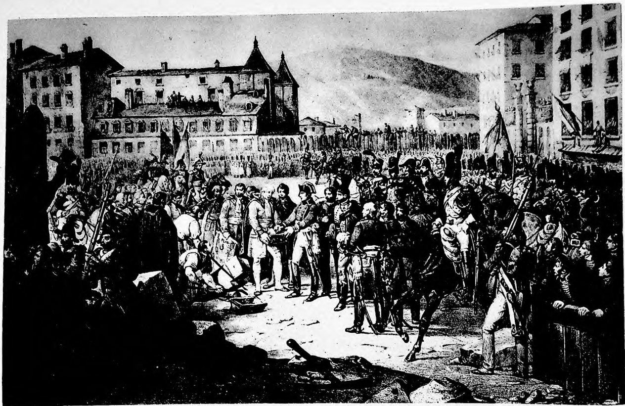
POSE DE LA PREMIERE PIERRE DES NOUVELLES FAÇADES DE BELLECOUR, PAR BONAPARTE, EN 1800.
